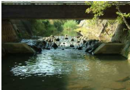
56号(04.12)北川親水化工事第2期目 がはじまる(魚道が設置される)
